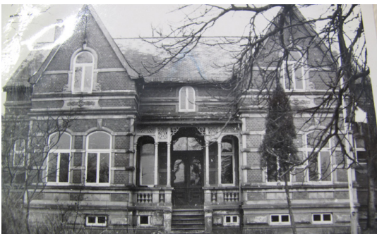
Abb. 1: Ehemalige Suchtklinik in der Neuenlander Straße
