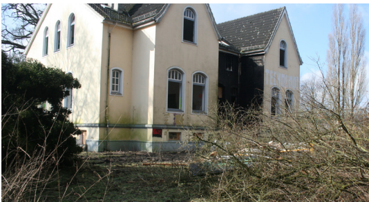
Abb. 2: Das alte Gebäude der Suchtklinik kurz vor dem Abriss im Jahr 2015
